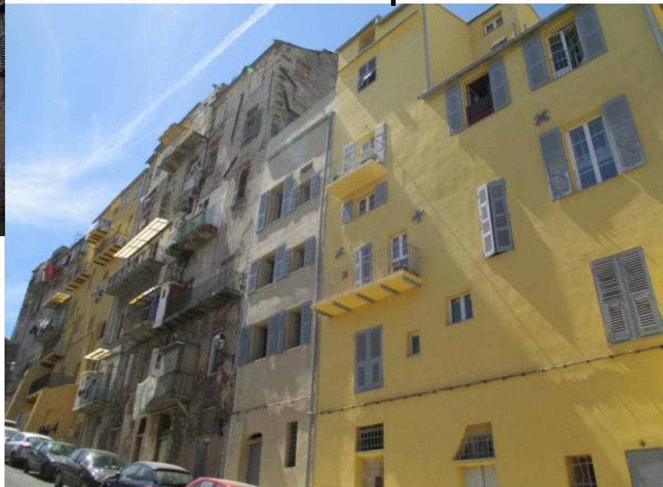
Rue du Colle – après travaux
