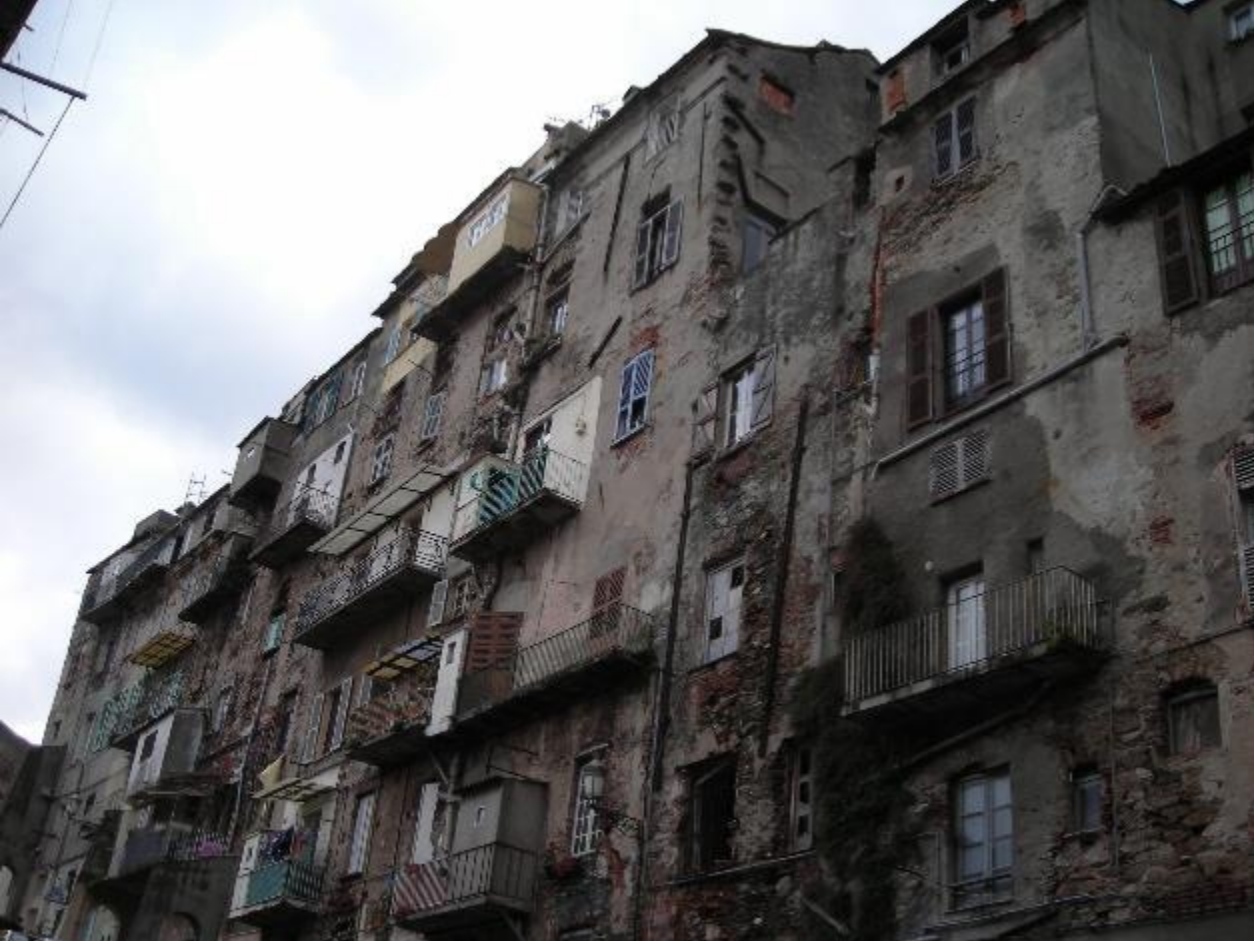
Rue du Colle – avant travaux
